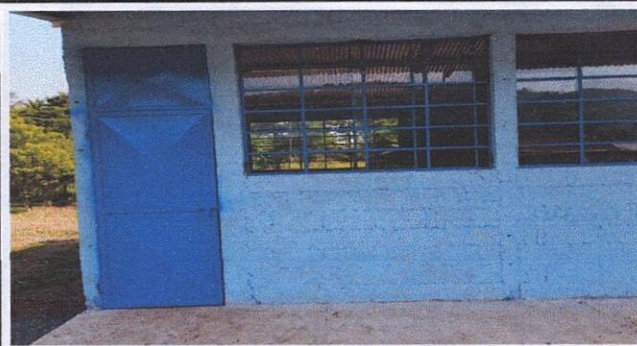
Foto 2: Colocación de puertas en cada aula y aplicación interior y exterior de pintura en ambas aulas .
