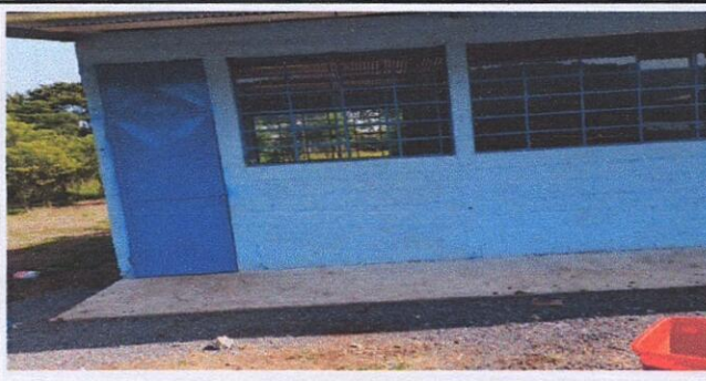
Foto 5: Colocación de tres ventanas por aula, con sus respectivos transparentes
