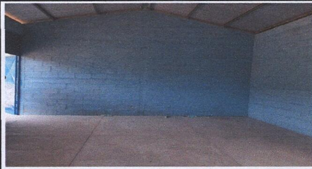
Foto 4: Fundición de piso de concreto con acabado de cemento liquido en ambas aulas .
