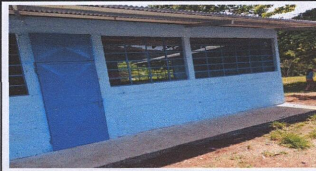
Foto 6: Fundición de corredor de concreto .
